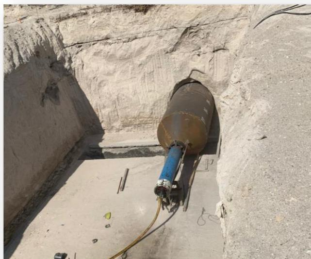
La tierra que entra en el interior de la tubería durante su instalación es totalmente extraída una vez terminada la perforación. Si el tramo de tubería hincado no cubre la distancia del proyecto se procederá a desmontar el equipo, bajar otro tramo de tubería, alinear y soldarlo y nuevamente, se alinea y nivela el martillo neumático, iniciándose el proceso de hincado hasta completar la distancia requerida.
