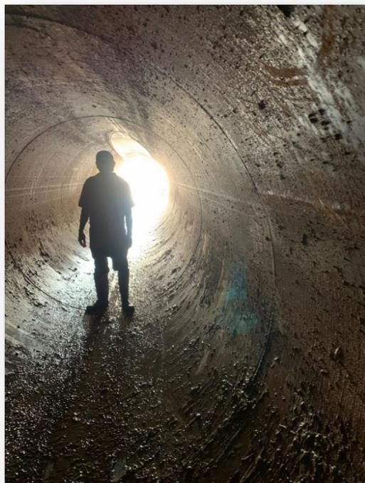
Como la tierra va quedando dentro del tubo, al irse desplazando este, al término del hincado procedemos de inmediato a la limpieza interior del tubo, para esto utilizamos un hidro-jet de alta presión o manual según sea el caso. Terminada la limpieza interior de la camisa se procede al retiro de todos los equipos y materiales que se hayan utilizado.
